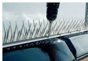
5. Installer sur les rebords de fenêtre, conservatoires etc. Il est recommandé que le mastic soit utilisé autour des pénétrations pour obtenir une étanchéité à l'eau.
